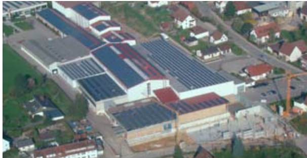
Une puissance de 800 kWp installée sur les toits de nos bâtiments
